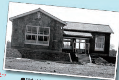
●建設当初の広瀬浄水場ポンプ室
