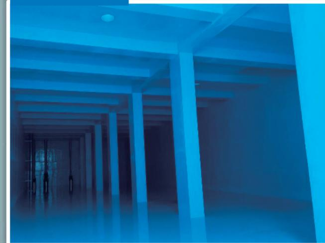
東西約25m、南北約40m、地上3m、地下3.5m、有効水深5.5m、容量は5,000m<sup>3</sup>の、鉄筋コンクリート造の大きな水槽です。
