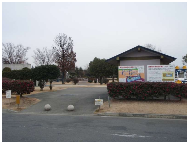
いせさき市民のもり公園給水場
