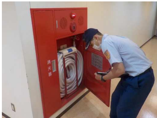
屋内消火栓設備の消防検査
