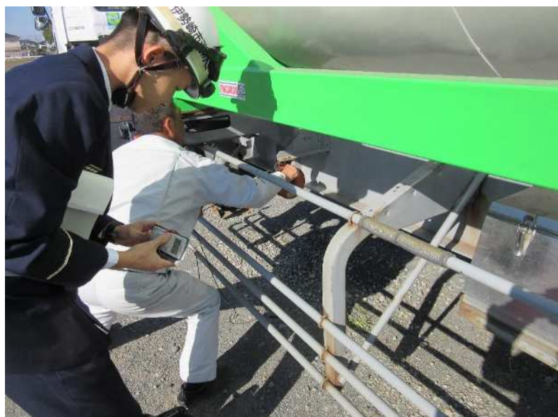
移動タンク貯蔵所完成検査
