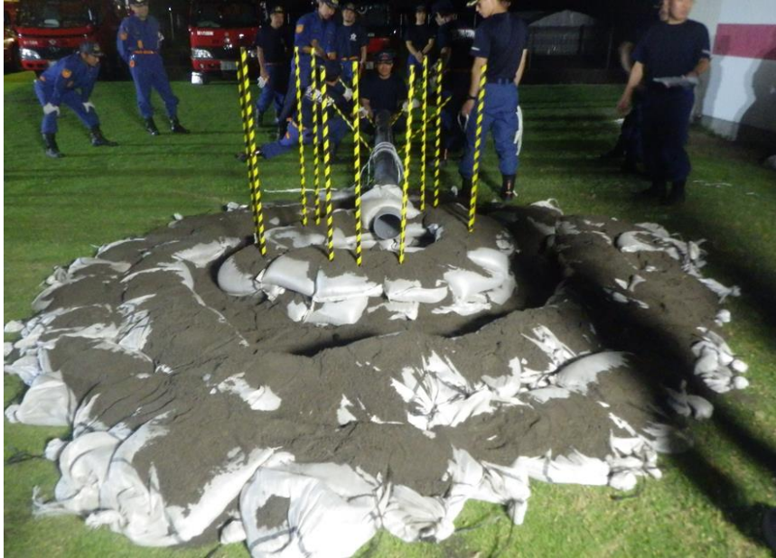
※令和6年度水防訓練（釜段工）
