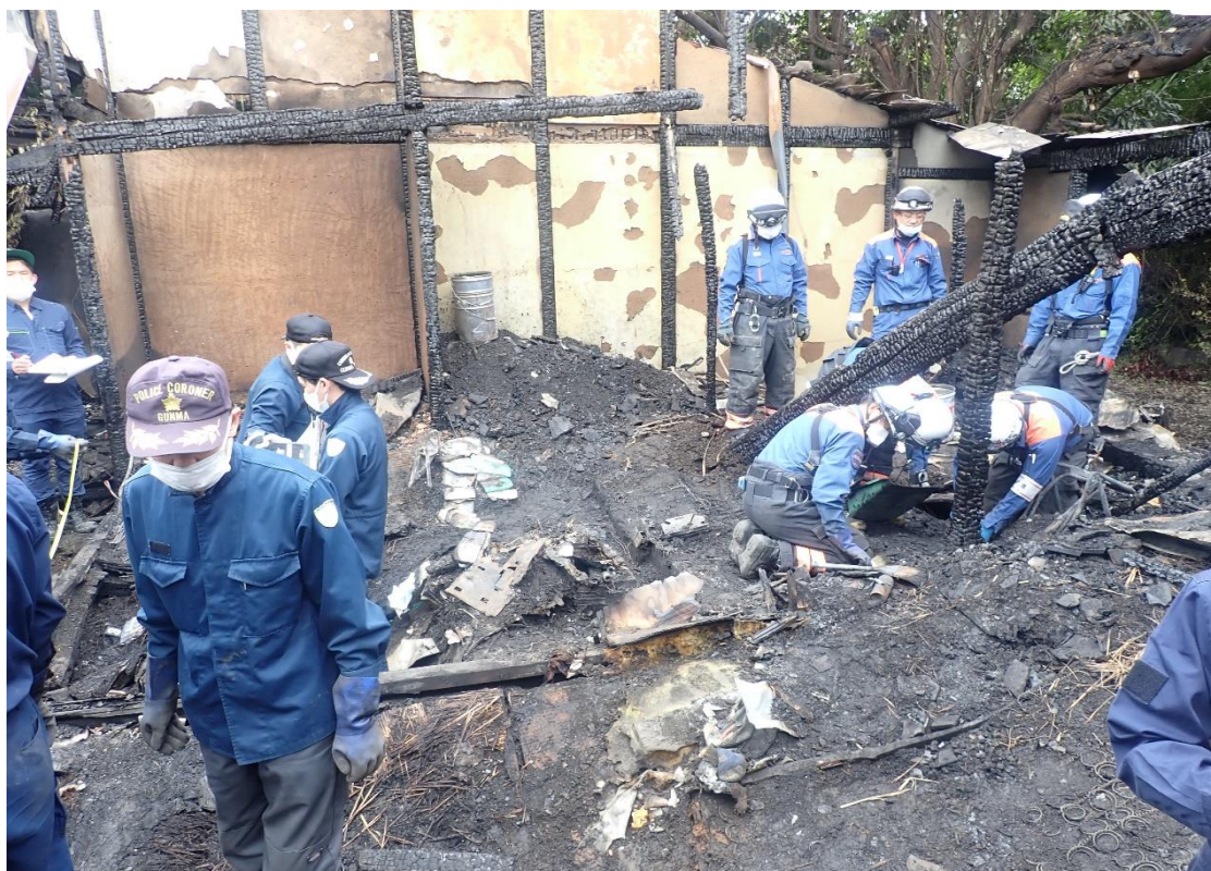
警察機関と合同で実況見分を行っている状況
