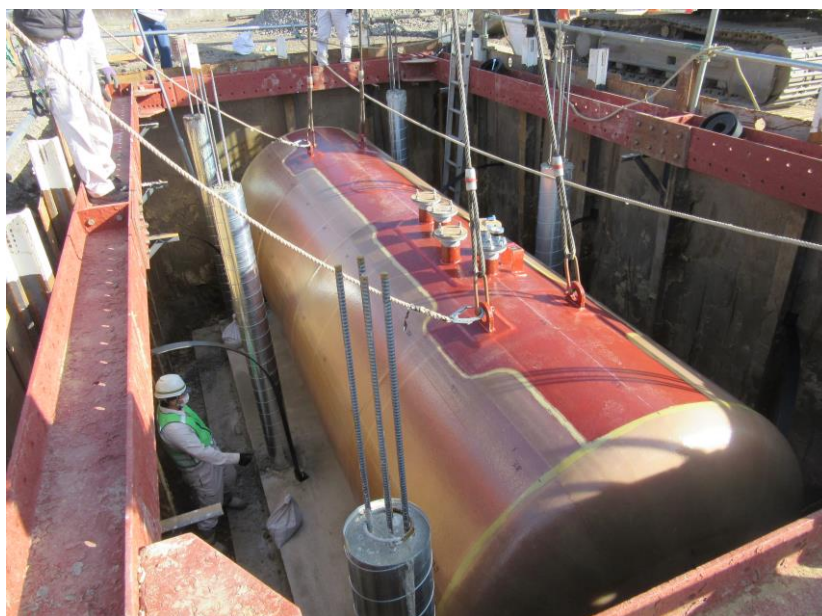
地下タンク据付検査
