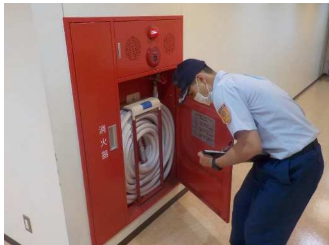
屋内消火栓設備の消防検査
