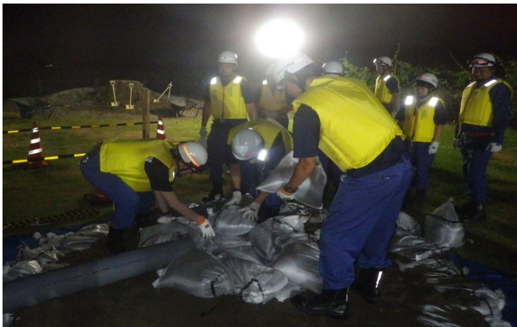
※令和7年度水防訓練（釜段工）
