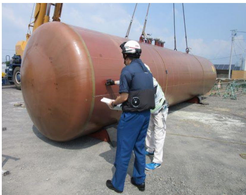
完成検査写真
