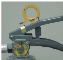
× 安全栓の抜けかけ
