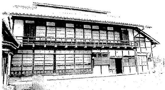
前橋市の養蚕農家(主家兼蚕室) 昭和29年(1954) 近代養蚕の完成形
