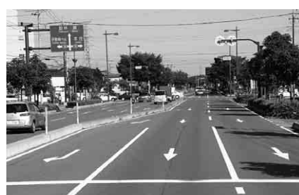
幹線道路の進捗状況は
