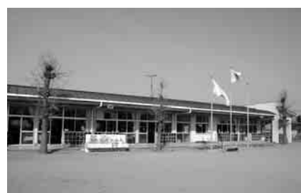
老朽化している園舎の対応は
