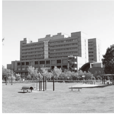
健全な経営に努めていく市民病院
