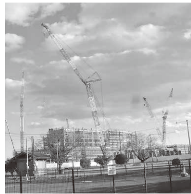
造成中の産業団地
