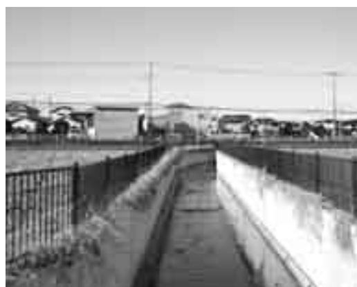
排水対策の現状は
