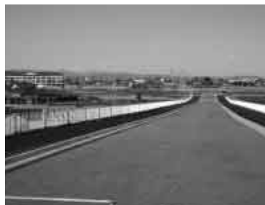
整備が進む中島橋北詰の道路
