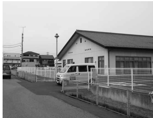
公民館周辺道路の拡幅を
