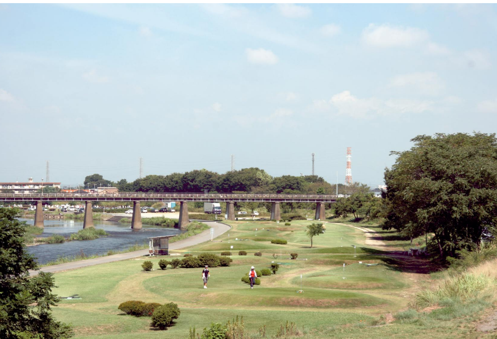
境広瀬川緑地グラウンドゴルフ場
