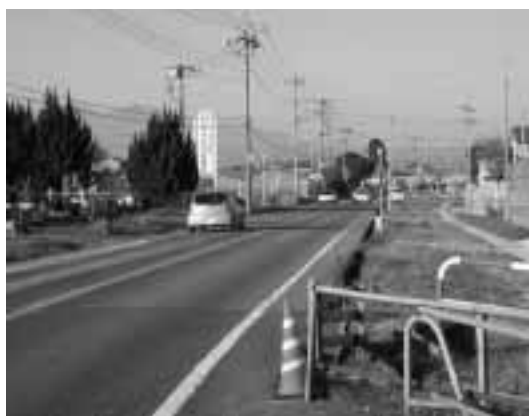
市道122号線の進捗状況は
