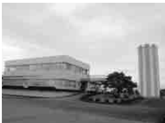
水道事業用建物の耐震対応は
