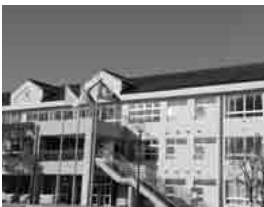
学校の屋根に設置してある太陽光発電
