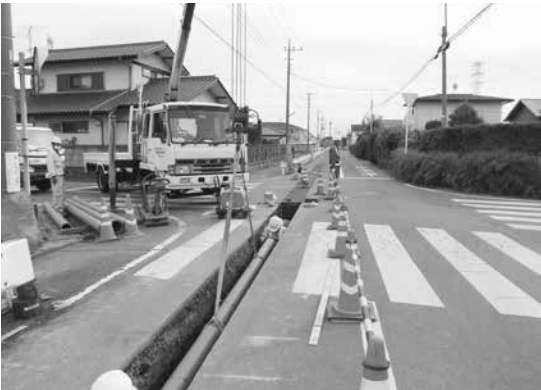
石綿管更新事業配水管布設替工事
