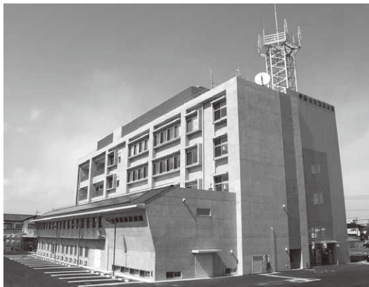
新たな消防本部庁舎
