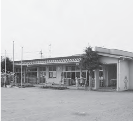
改築予定のあずま幼稚園園舎
