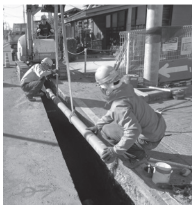
水道管の設置
