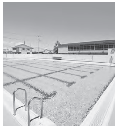
改築後プール開きをした名和小学校
