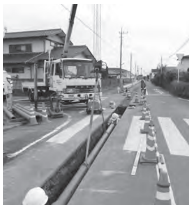
水道管の更新工事
