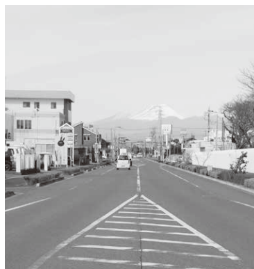
無電柱化された都市計画道路
