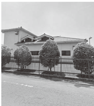
農業集落排水処理施設
