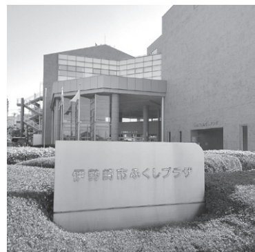
設備改修工事をするふくしプラザ
