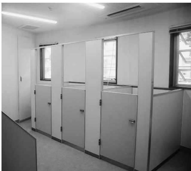
幼稚園トイレ改修工事 (宮郷幼稚園)
