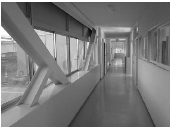
第一幼稚園園舎の耐震補強
