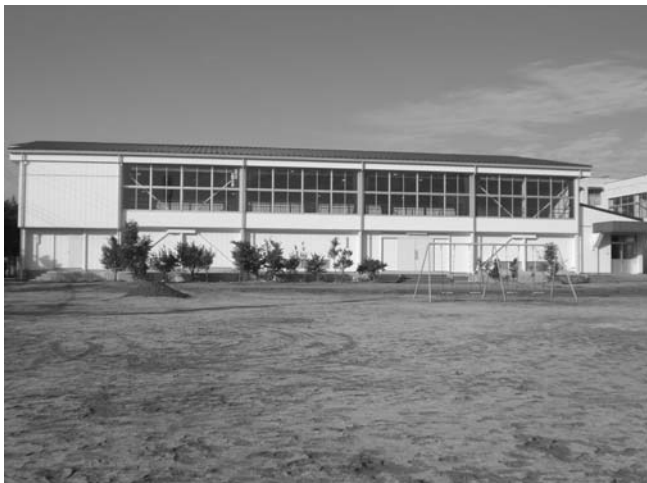
殖蓮第二小学校体育館の耐震補強
