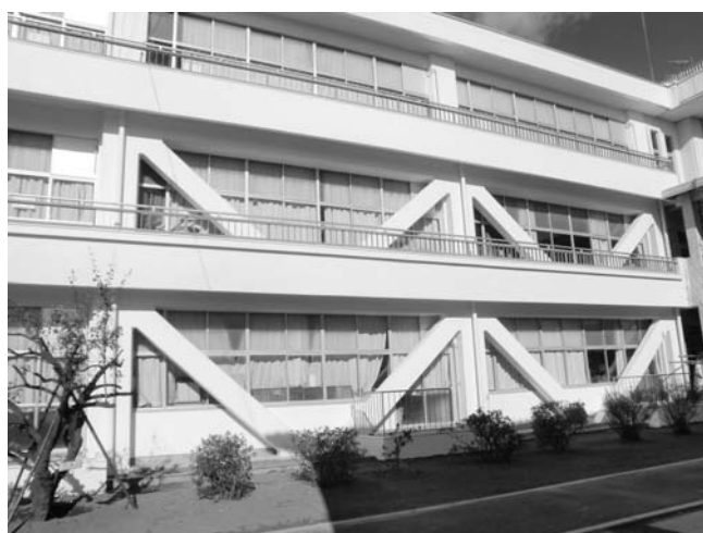
采女小学校校舎の耐震補強
