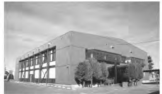
境北中学校体育館耐震補強工事
