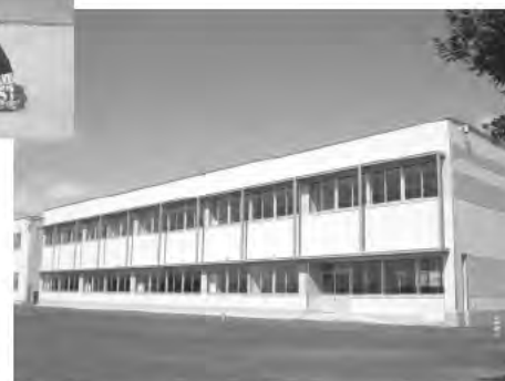
宮郷中学校校舎増築工事
