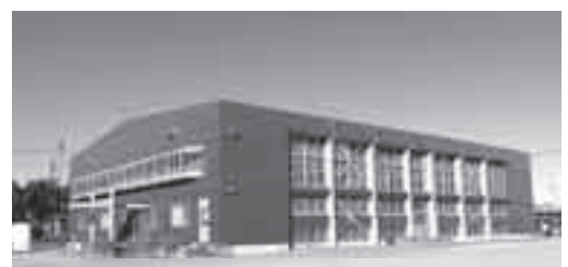
境西中学校体育館耐震工事
