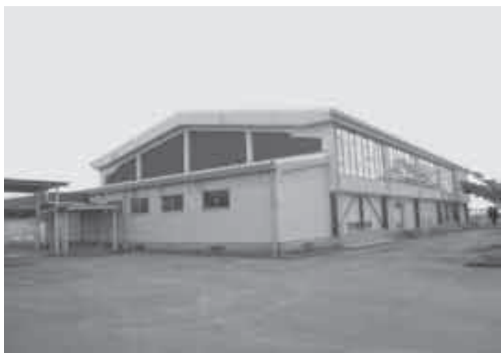
豊受小学校体育館の耐震補強
