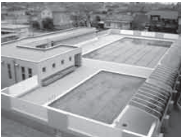
宮郷小学校プール改築建築工事
