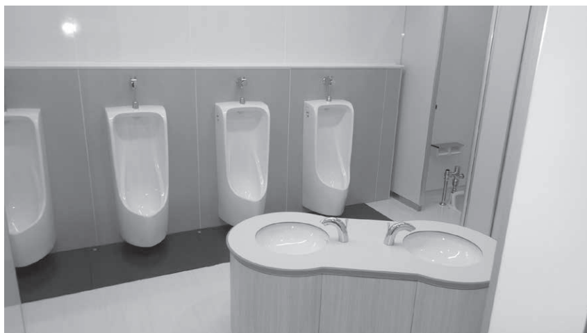
小学校のトイレ改修（北第二小学校）
