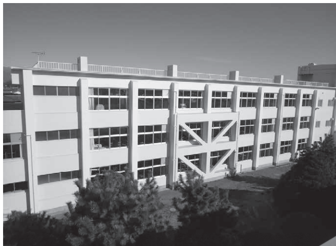
第三中学校校舎の耐震補強
