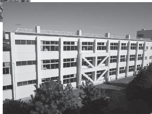
耐震補強工事
