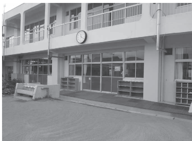
南幼稚園園舎の耐震補強
