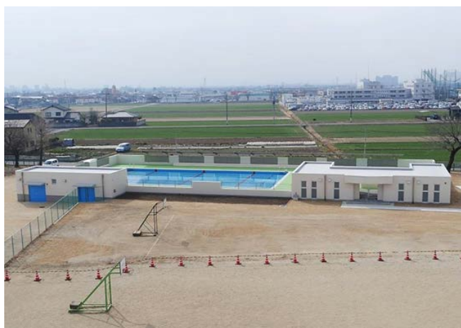
プール改築工事（三郷小学校）
