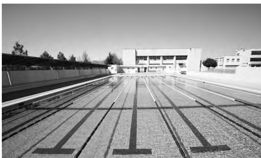
小学校プール改築工事 (あずま小学校)
