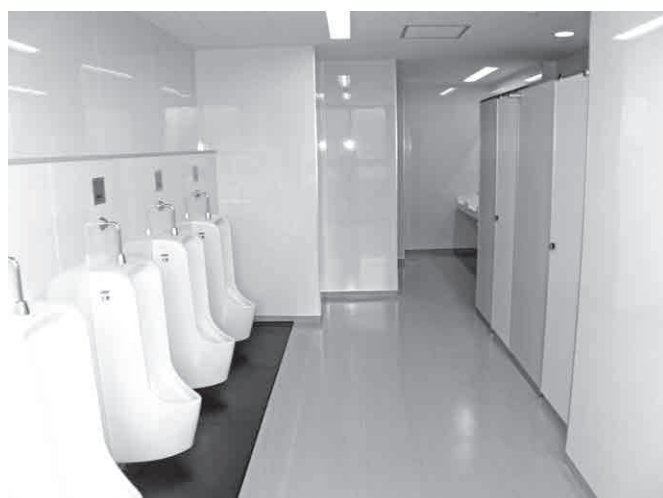
中学校トイレ改修工事（第二中学校）
