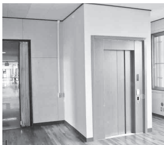
小学校エレベーター設置工事 （赤堀南小学校）
