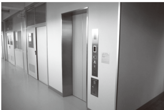
第一中学校エレベーター設置工事
