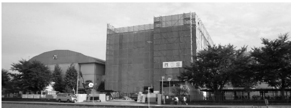
建設中の四ツ葉学園中等教育学校
