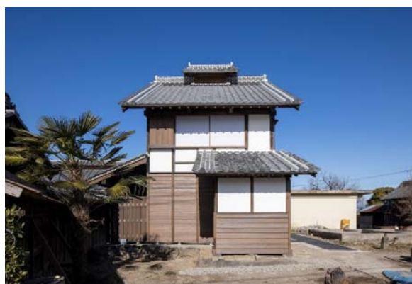
田島弥平旧宅別荘整備工事が完了
