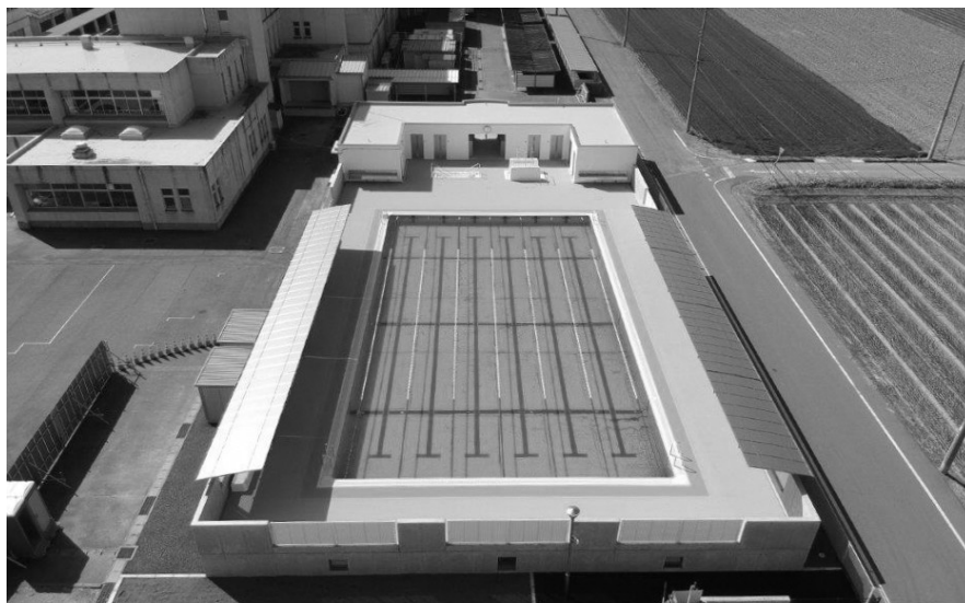
中学校プール改築工事 (宮郷中学校)
