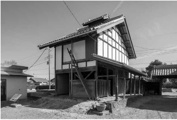
田島弥平旧宅別荘改修工事完成
