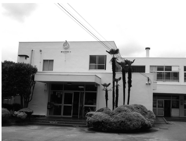
外壁改修工事（豊受小学校）
