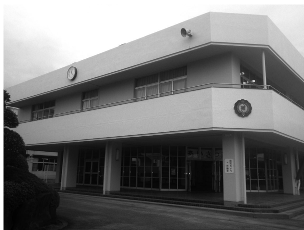
外壁改修工事（殖蓮中学校）
