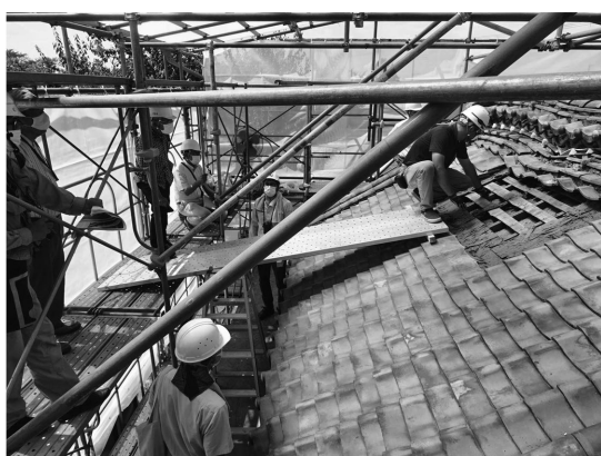
東門整備工事状況
