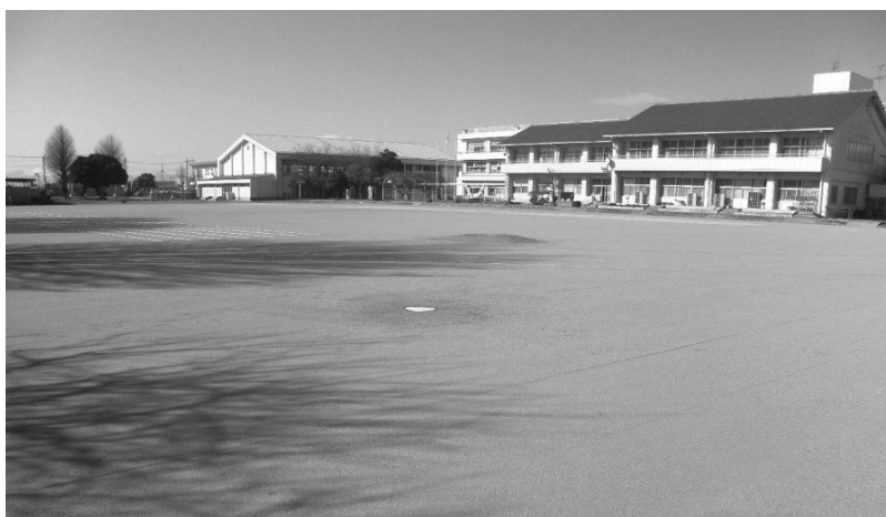
校庭整備工事（境采女小学校）
