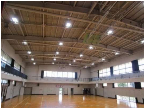
照明設備の更新工事 (LED 化)
